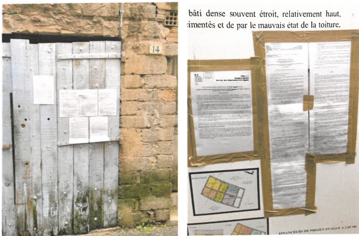
Figure 6 - Affichages sur les lieux du projet constaté le 15 novembre 2021 rue Basse et Rue du Marché (photo : J. NICOLAS)
